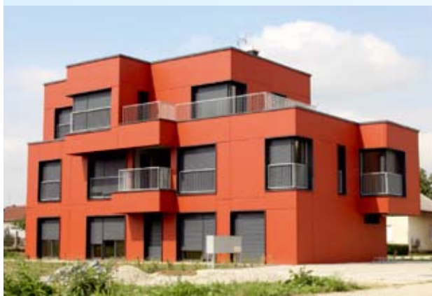
PRVA ECO SANDWICH KUĆA Koprivnica
